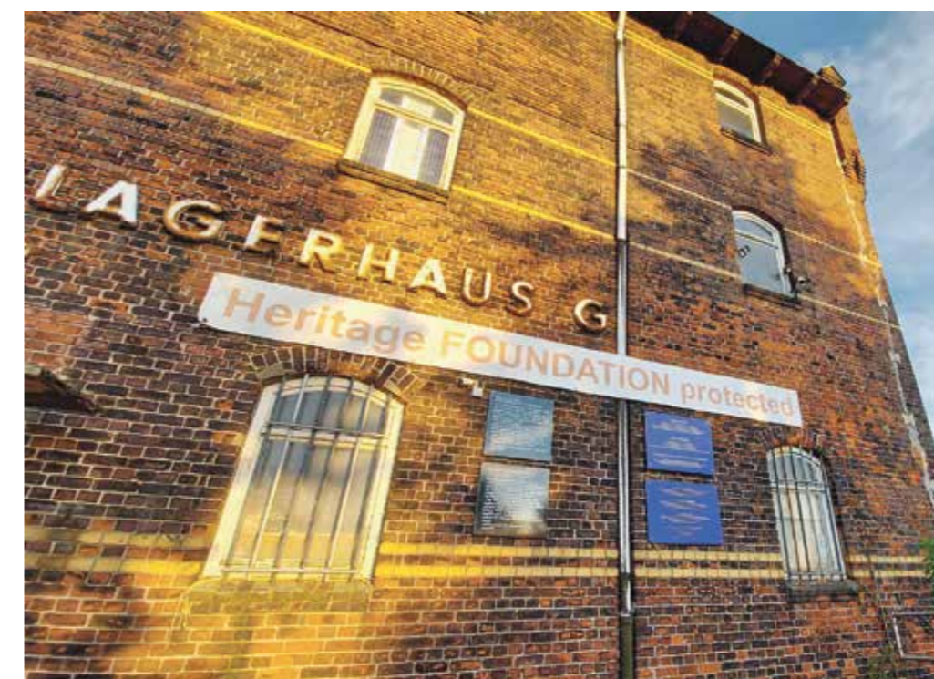
Das Lagerhaus G wurde von 1903 bis 1907 erbaut – ursprünglich als ein Doppelsenble mit dem baugleichen Lagerhaus F, das zum Kriegsende jedoch vollständig zerstört und später neu aufgebaut wurde.
